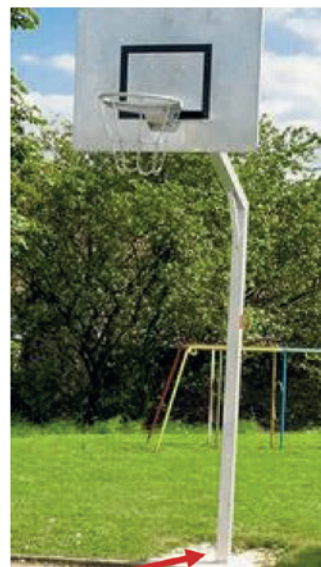
keine Fundamentfreilegung notwendig
